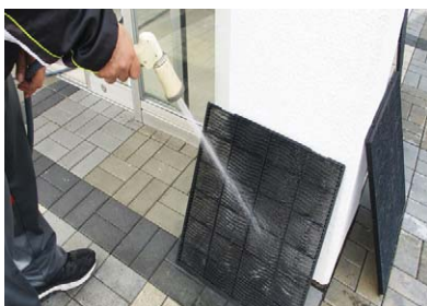
エアコンフィルターの清掃②
